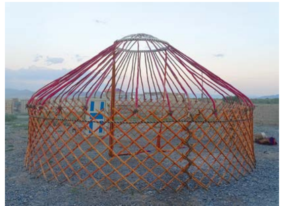
Рис. 2. Деревянный остов юрты. Цэнгэл, Баян-Өлгий, август 2015.
