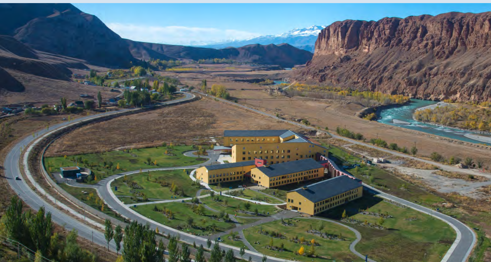
Нарынский кампус УЦА (объекты 1-ого этапа строительства) был открыт в 2016 году.
